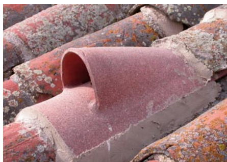
Entrada de los nidales interiores Photo : P. Pilard
