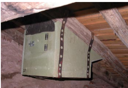
Nidal instalado bajo el tejado de la iglesia Photo : P. Pilard
